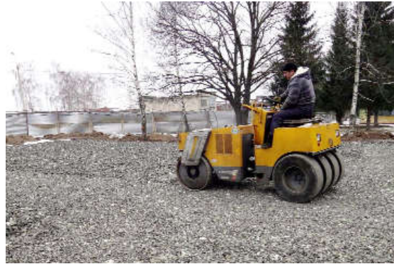
Vật liệu đá từ thủy tinh bọt trong thi công làm đường
