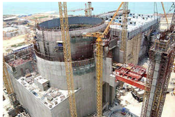
Công tác lắp dựng khu chính của lò phản ứng và tháp làm nguội nước bằng quạt (nhà máy điện hạt nhân tại Tây Ban Nha)
